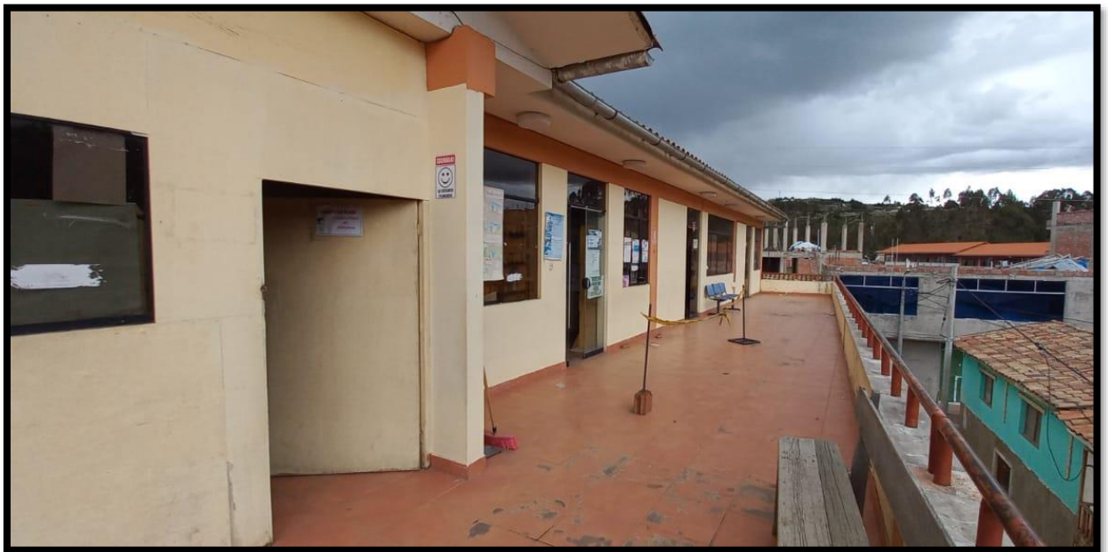
Imagen 19: Vista de la fachada del Puesto de Salud del centro poblado de Tinke
